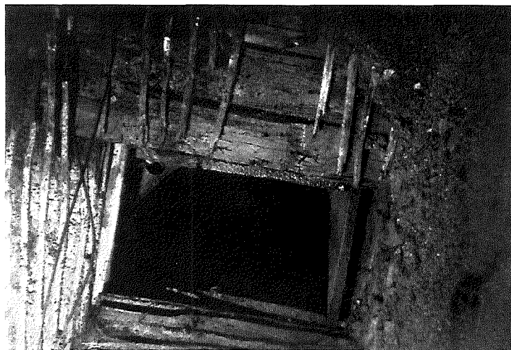
18. Blick in den Feuerraum mit Rauchöffnung
