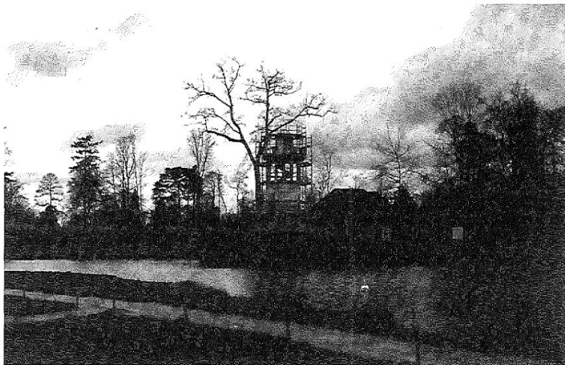
Abb. 5: Der Marborough-Turm im Baugerüst, 2002 Foto: Nina Gorgus
