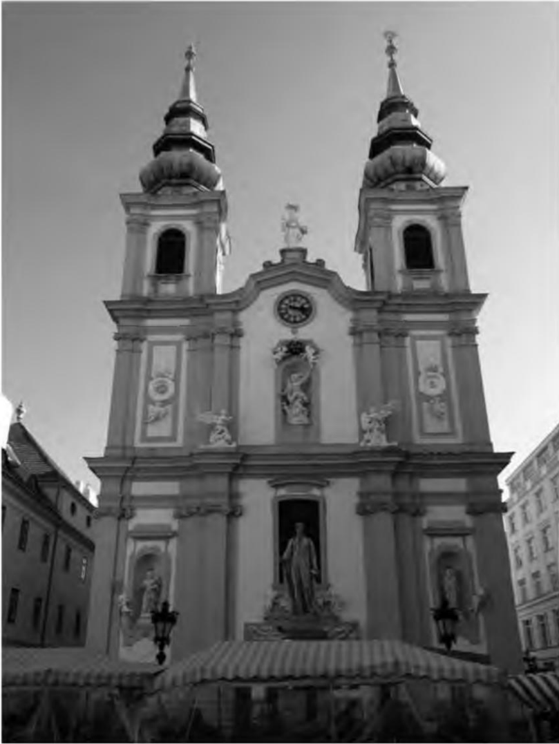
Abb. 1 Fassadenansicht Mariahilfer Straße
