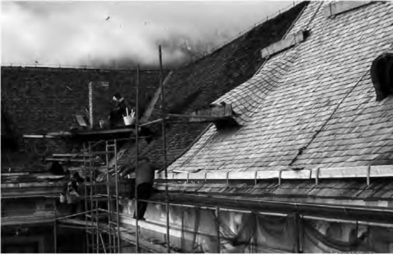
Abb. 7 Eindecken des Schlossdaches mit Lärchenschindeln, 1984 Foto: E. Haar
