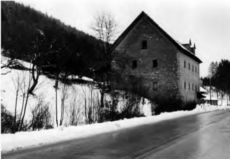
Abb.6 Der Ennshofspeicher vor der Renovierung, 1972 Foto: K. Haiding
