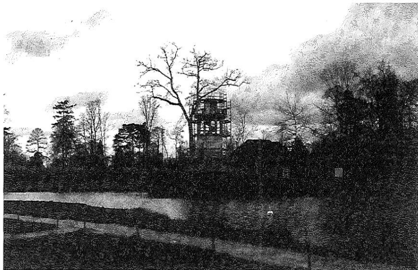
Abb. 5: Der Marborough-Turm im Baugerüst, 2002 Foto: Nina Gorgus
