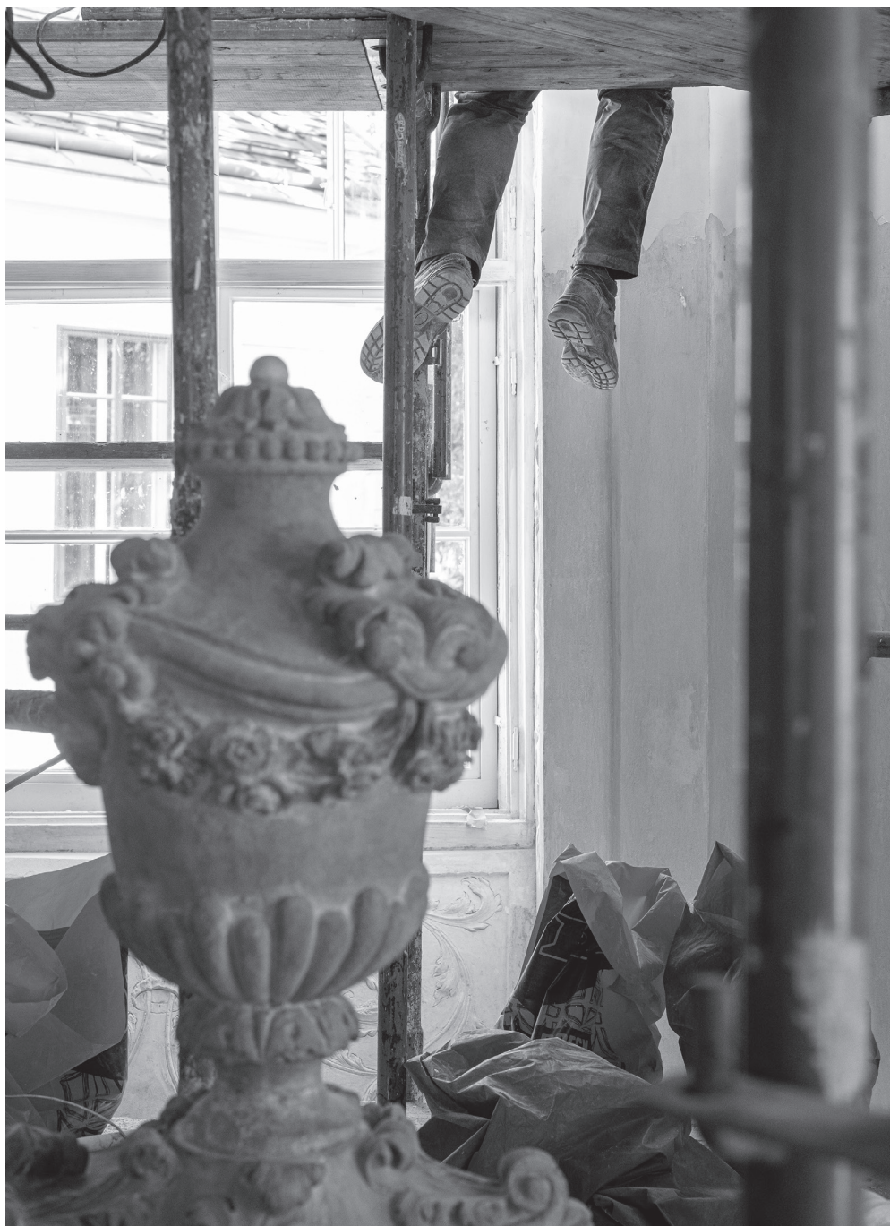
Hände und Füße auf der Baustelle. Fotos: Kollektiv Fischka / Kramar
