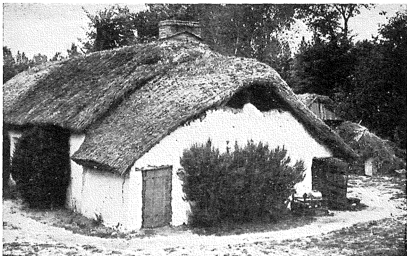
Abb. 7. Haus mit Giebelöffnung (Lüftung) unter dem Dachfirst. St. Jean-de-Monts.
