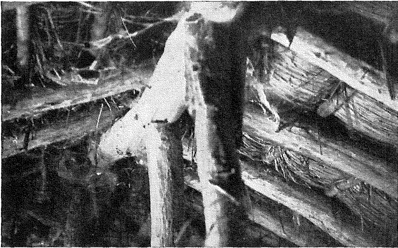
Abb. 12. Haus 1: Dachgerüst mit Bodenständern der Firspfette.
