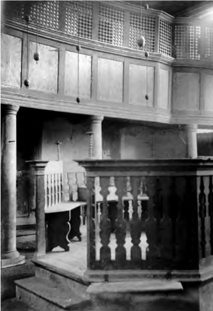
Abb. 4 Synagoge in Hornburg, Foto vor der Translozierung des Inventars und einiger Architekturelemente, vor 1925 (nach: Wilhelm, wie Anm. 25)
