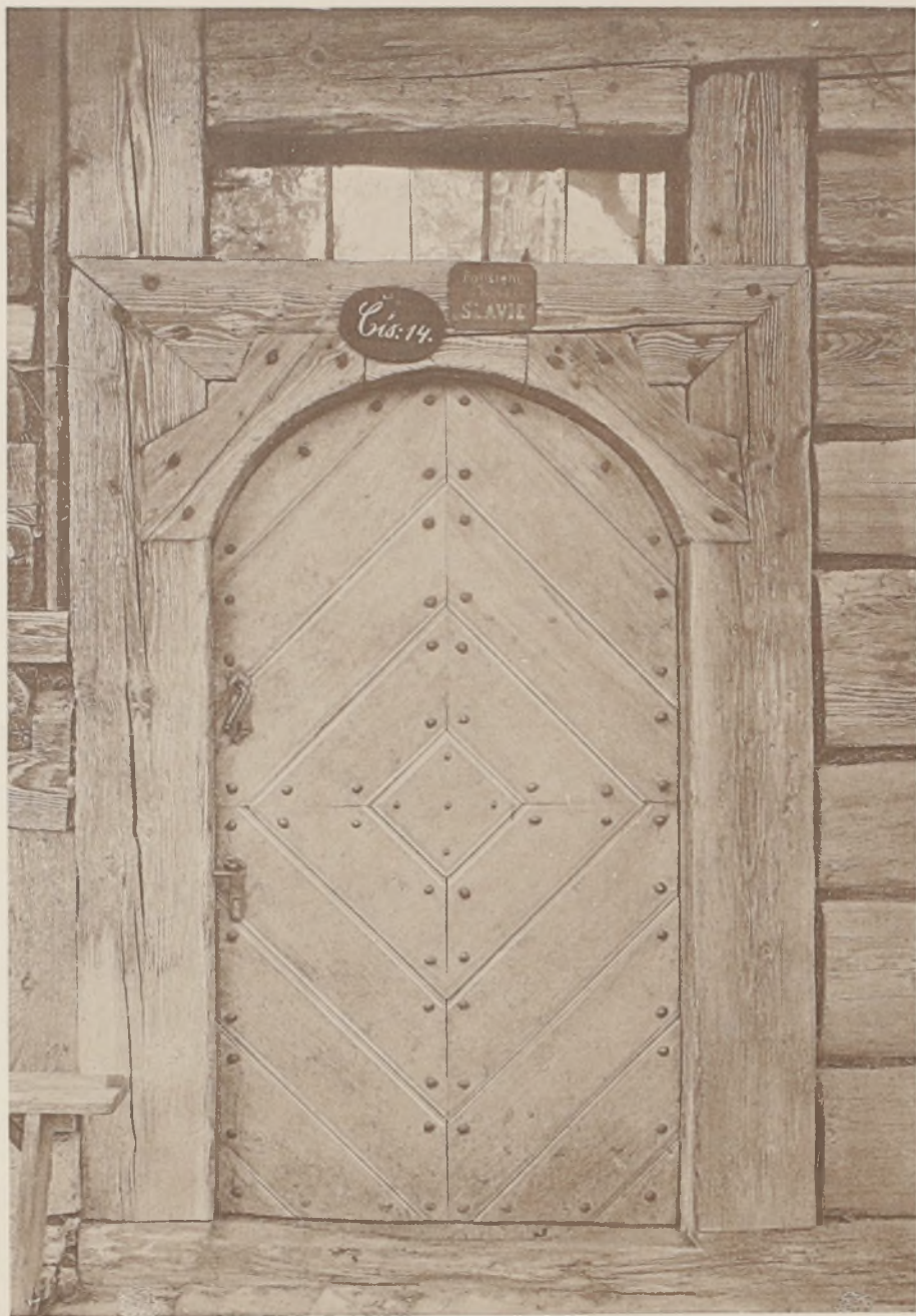
TÜR IN HUKVALD. VORGARTEN IN MEZIBRODÍ.
