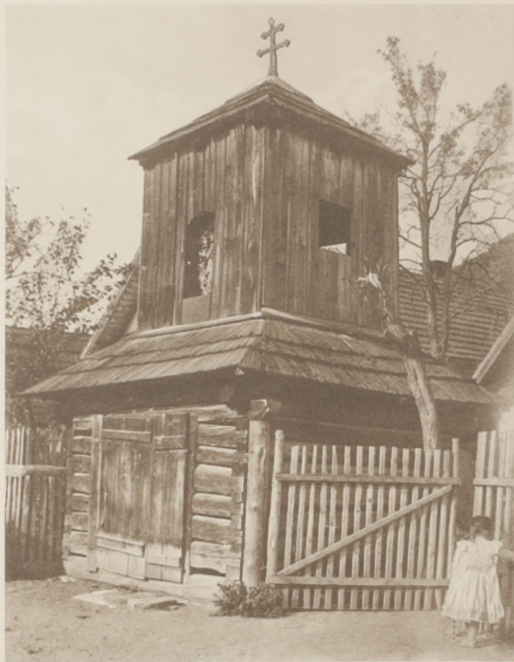
GLOCKENTÜRME IN VRBĀ UND HORNĀ REVÚCA.
