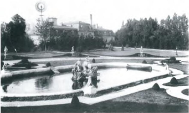
Windrad zur Wasserversorgung des Schlosses und des Spitals, Kitzsee um 1910, Ethnographisches Museum Schloss Kitzsee
