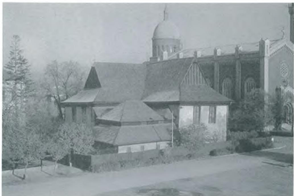
13 Kežmarok/1717 — Artikularkirche, von Georg Mittermann auf dem Grundriß des griechischen Kreuzes gebaut.
