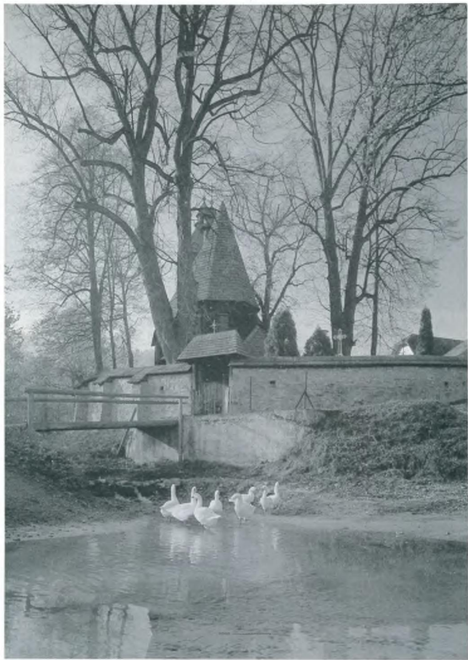
7 Hervartov/1593—1596 — Gotische Blockbaukirche.
