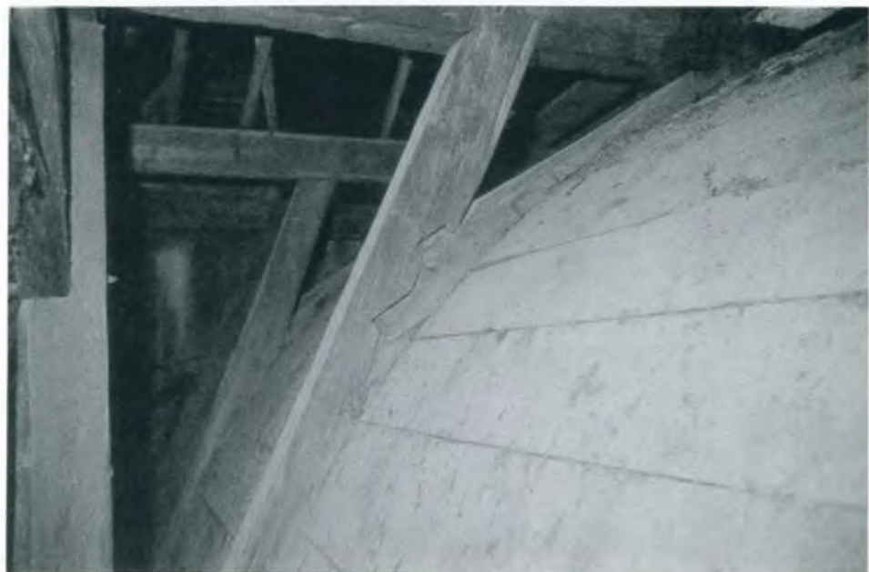
5 Hronsek/1725—1726 — Konstruktion des Gewölbes.
