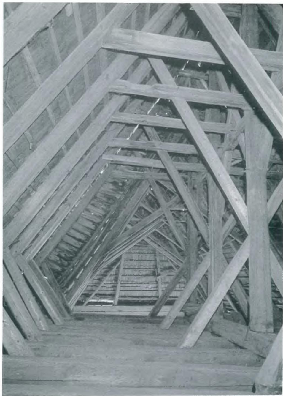
6 Tvrdošín/2. Hälfte des 15. Jhs. — Konstruktion des Dachstuhles
