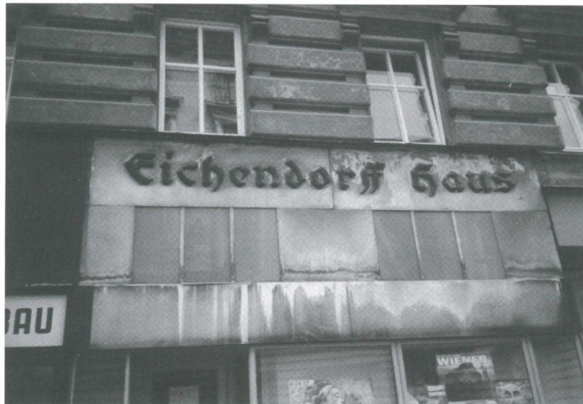
Abb. 1: Portal Stadiongasse 9, um 1995.
