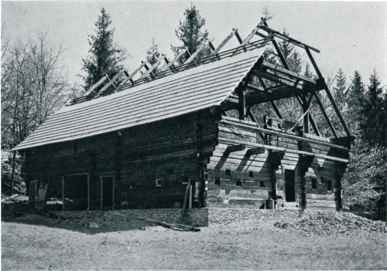
Abb. 17: Dachgerüst des Salzer-Hauses aus Schlaipf bei Rennweg, Katschtal, beim Wiederaufbau im Kärntner Freilichtmuseum Maria Saal (Foto Dr. O. Moser, 1962).
