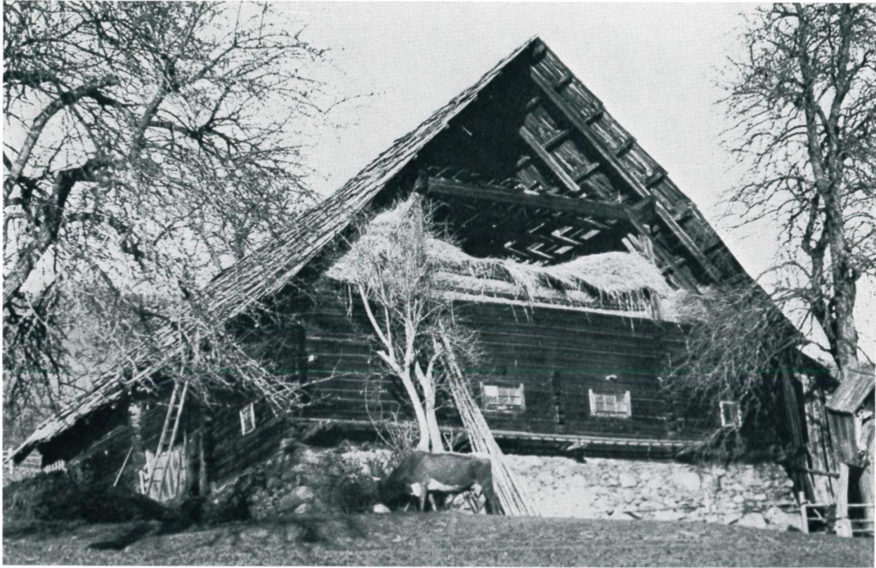
Abb. 21: Ortschaft Hühnersberg, Gem. Lendorf am Lurnfeld: Hof vulgo Kristebauer. Alpine Längsscheune in Blockbau mit Pfettenstuhldach. Der mächtige Pfettenstuhl mit seitlichen Fußstreben und den kräftigen Rofenbäumen ohne Firstpfette ist deutlich erkennbar. Das Bauwerk zeigt überdies ein sehr charakteristisches Merkmal dieser Oberkärntner Dachlandschaft, nämlich den völlig offenen oder nur wenig abgeschlossenen („verschalten“) sonnseitigen Dachgiebel, wie er bis zum Anfang des 20. Jahrhunderts bei vielen Wohn- und Wirtschaftsgebäuden üblich war (Foto Dr. O. Moser 1945).
