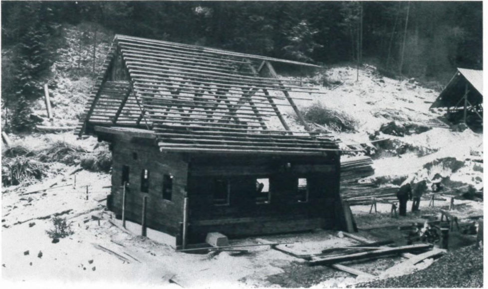
Abb. 9: Über der wiederaufgebauten Schulstube konnte das Dach im Dezember 1977, noch zeitgerecht vor dem großen Schneefall, errichtet werden. Das strenge Winterwetter verhinderte vorerst den Aufbau der übrigen Räume.
