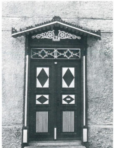
Abb. 2: Haustür mit Ziergiebel vom Haus Abb. 1.
