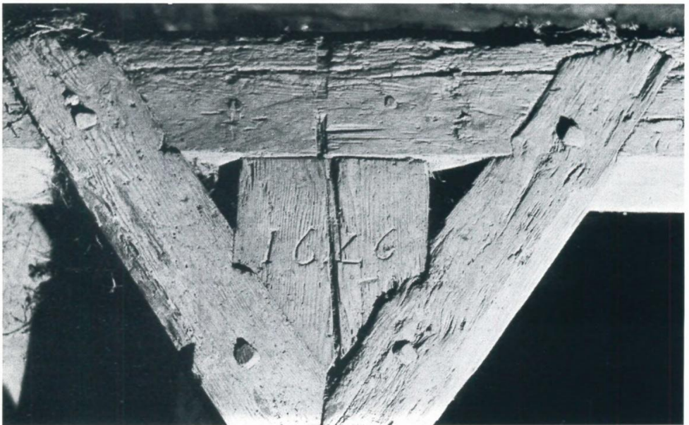
Abb. 4: Tenssäule, datiert 1626, mit Bundtram des Scherhaxenstuhles im Stadel des Hauses „Weger“. Aufn. M. Kislinger, 1965.
