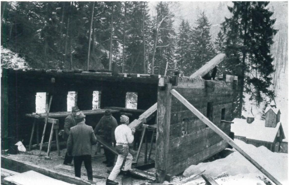
Abb. 8: Wiederaufbau der alten Prätiser Schule im Österreichischen Freilichtmuseum. Die Blockbauwände der alten Schulstube sind bereits aufgezimmert. An der Westfassade sind die beiden klein gebliebenen Fenster gut erkennbar. Eben wird die „Mauerbank“, der oberste Balken der Blockwand, aufgelegt.
