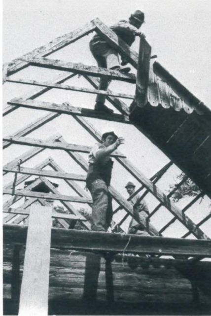
Abb. 7: Am 9. Mai 1977 wurde mit dem Abbau der alten Schule begonnen. Nach planmäßiger Kennzeichnung wird der Bau sorgsam in seine Bestandteile zerlegt.
