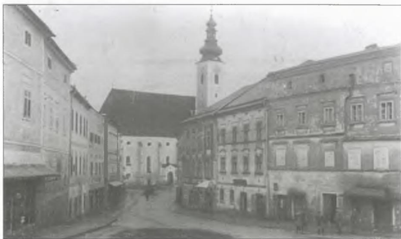
Peuerbach, Marktzentrum, anonyme Photographie um 1900, Bautenarchiv G.Dimt
