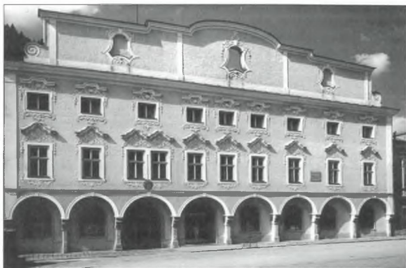
Drei Häuser hinter gemeinsamer Fassade.
