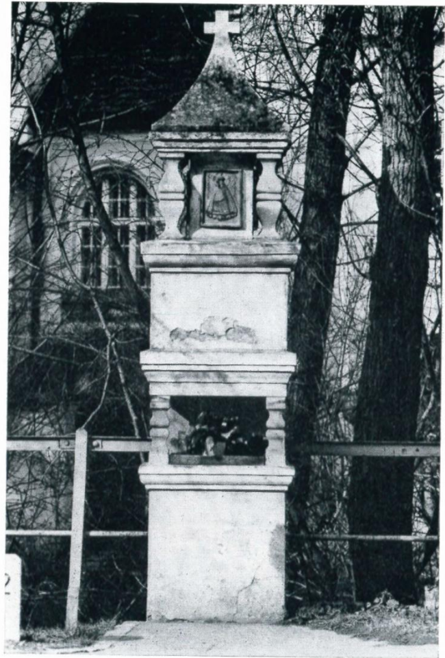
16. Hinterbrühl (BH Mödling) Vierseitiger Pfeiler mit zwei übereinanderliegenden Nischen und vierseitigem Pyramidendach mit Kreuz aus Stein (ein Querbalken) als Bekrönung. Mitte 17. Jh.; Bild Mariazeller Muttergottes
