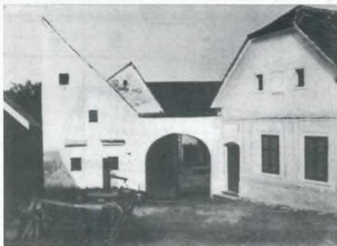
Abb. 5a: Oberschützen. Haus Nr. 57. Straßenansicht, um 1930 (nach A. Haberlandt, Österreichische Kunsttopographie, Abb. 144).
