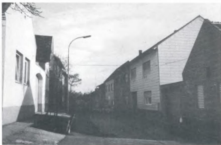
Abb. 2b: Gleiche Fassadenzeile heute.
