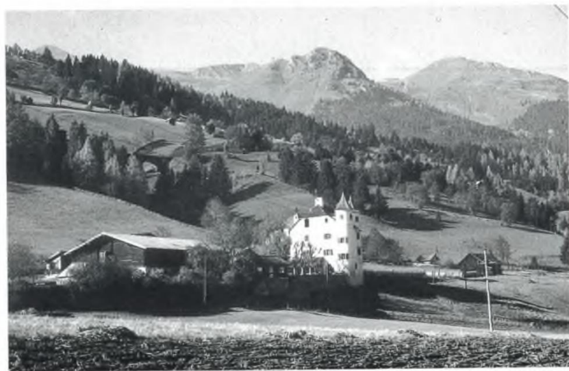
Abb. 4: Weitmoserschlößl in Bad Hofgastein, erbaut 1554; Foto: K. Conrad
