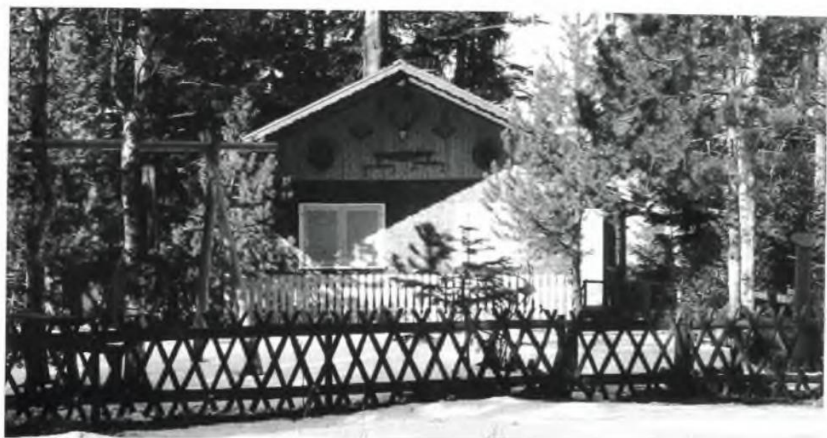
Abb. 6: Wenngleich im Bergmahd generell selten, werden doch einzelne – vor allem die kleineren – Grundstücke eingezäunt. Die Hütten sind oft liebevoll geschmückt; Foto: D. Jo. Peter.
