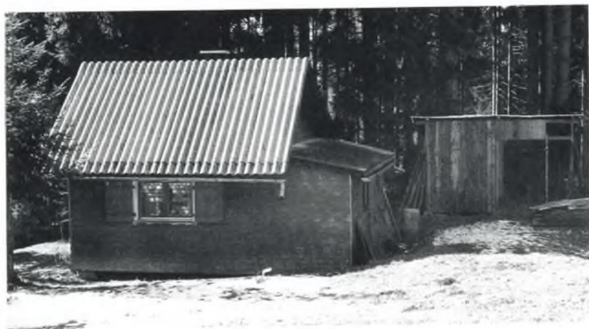
Abb. 4: Obwohl sich manche der älteren Ferienhütten recht bescheiden ausnehmen, wurden vielfach auch sie im Laufe der Zeit bereits durch An- und Umbauten erweitert; Foto: D. Jo. Peter.
