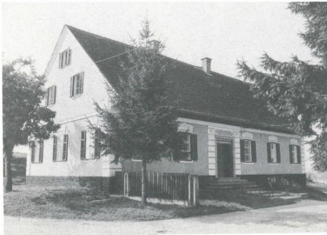
Abb.40: vlg. Rumpf, RO 43, 1888: breitgiebeliger Mauerbau mit reicher rustizierender Verzierung (s.Kap. 8.6.).
