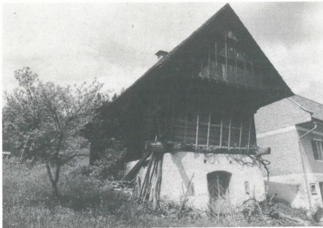
Abb.32: KO 46, 1777: Kellerstöckl bestehend aus Stübl mit darunterliegendem Keller und Preßraum. An der Vorderseite und an der linken Traufseite war ein Gang vorhanden.
