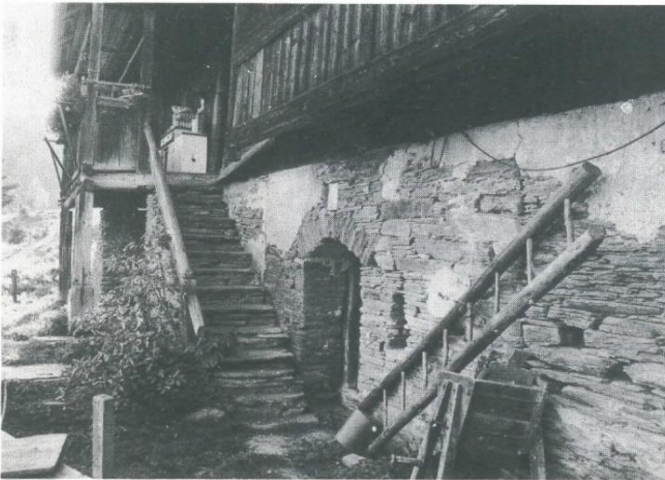
Abb.26: vlg. Tschreapl, TR 36, 2.H.18.Jh.?: Aufgang zum Gang, der aus einem breiten, auf Holzstützen ruhenden Teil und einem schmalen Gang besteht.
