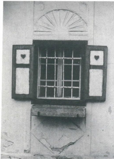
Abb.20: vlg. Waldschneider, WA 5, sekundäre Vermauerung um 1850: Blendrahmenfenster mit einfachem, genietetem Gitter; grün-weiß gestrichene Bretterläden. Putzverzierung durch Rosette und Rhombus.
