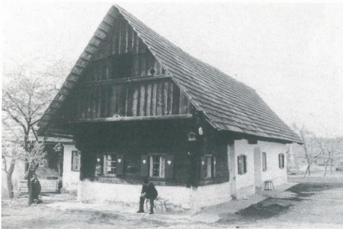
Abb.30: vlg. Hansbauer, SJ 75, 18./1.H.19.Jh.: Talhof in Gemischtbauweise, der durch einen besonders großen Quergiebel erweitert wurde.
