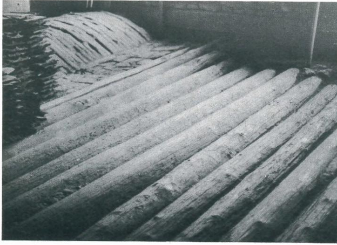
Abb.13: vlg. Grabenwechsler, OI 35, kurz vor 1850: Oberseite einer aus halbrunden Hölzern gefügten Doppelbalkendecke. Links im Hintergrund ist das Gewölbe der ehemaligen Rauchküche zu sehen.
