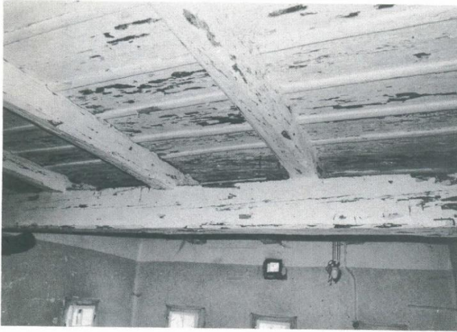
Abb.9: vlg. Picker-Gastkeusche, PI 12, 1.H.19.Jh.: Tramdecke in der Stube (unbewohnt). Auf einem Unterzug liegen drei firstparallele Träme, darauf eine Bretterlage mit Fugenlattung.
