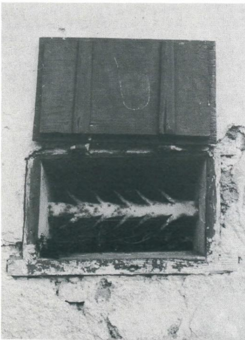
Abb.18: vlg. Teichtsteffl, SJ 6, Mauerteil 2.Viertel 19. Jh.?: Fenster der Speisekammer. Eingestemmter Zargenstock, durch zackig ausgeschmiedetes Eisen- band gesichert und durch ein- fachen Klappladen verschließ- bar (wohl Sekundärverwendung).
