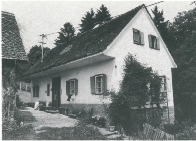
Abb.31: vlg. Christ, GA 36, 1860/80: schmalgiebeliger Mauerbau mit Sparrendach; der vordere Teil des Hauses ist unterkellert.
