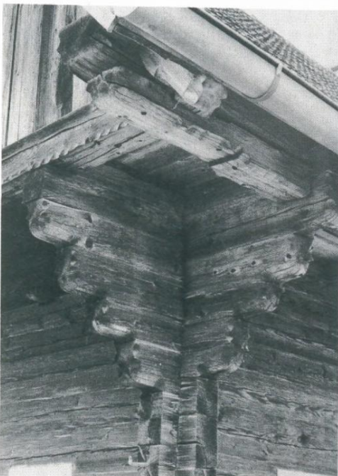
Abb.6: vlg. Lorenz, NE 15, 1818: Vorkragung der Konsol- hölzer und vorgelagerte, doppel- te Fußfette. Die untere Fuß- pfette zeigt die auch an den Trämen üblichen, reichen, be- sonders für Neurath charakteri- stischen Unterschneidungen.
