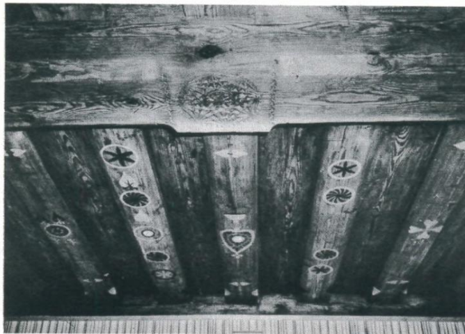
Abb.12: vlg. Kremser, PI 55, 1808: verzierte Riemendecke im Quergiebel. Der Unterzug trägt eine besonders reich gestaltete Rosette und an der nicht sichtbaren Seite die Datierung 1808. Die Riemen sind abgefärbt und in Schwarz, Rot und Weiß mit Rosetten, Herzen, einer Monstranz, einer Madonnendarstellung, dem Marienmonogramm und IHS bemalt. (Nach vorhandenen Bemalungsresten erneuert).
