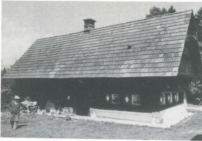
Abb. 37: vlg. Kaspar, SJ 88, 1748: Keusche in Blockbauweise. Der Sockel ist nur durch das Kalken der Holzwände vorgetäuscht (s.Kap. 8.3.).
