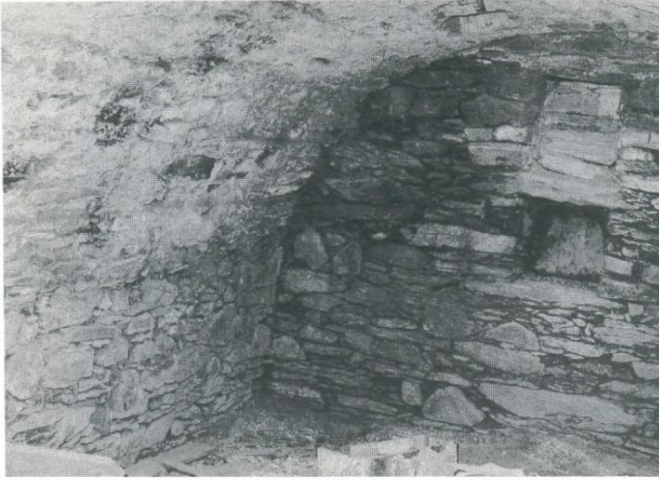
Abb.1: vlg. Berglesky, SIR 49: Keller mit Tonnengewölbe, Bruchsteinmauerwerk, 17. Jh.? (s.Kap. 8.2.).
