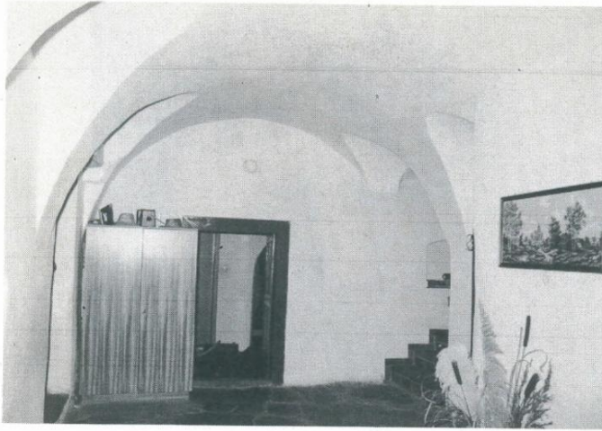
Abb.29: vlg. Hacklbauer, SIR 3, 18.Jh. u. spätere Erweiterungen: Flur ("Labm") mit Steinplattenboden und Tonnengewölbe mit Stichkappen. Rechts ist der Ausgang zu den über dem halb eingetieften Keller gelegenen Kammern zu sehen.
