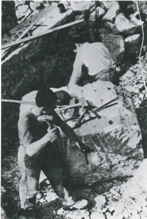
Das Zuhauen eines Felsblocks mit Hammer und Meißel
