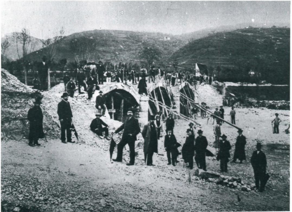
Brückenbau über den Progno in Tregnago
