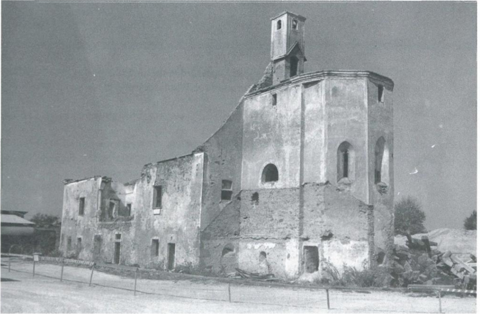
Abb. 261: Der Dürnhof bei Zwettl vor Beginn der Sanierungsarbeiten (Bundesbaudirektion, Geschäftsstelle Allentsteig)
