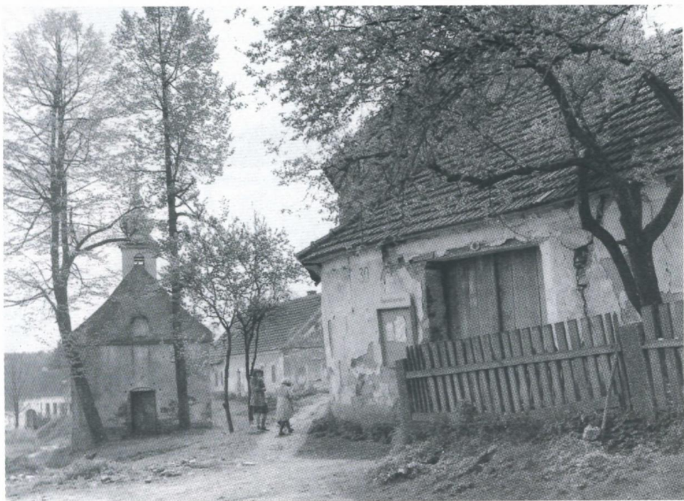
Abb. 11: Wurmbach 1961, Blick auf die Ortskapelle (Photoarchiv der Bundesbaudirektion)
