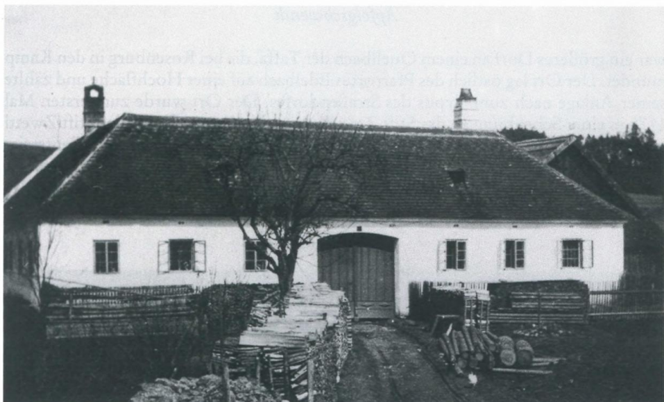
Abb. 27: Haus der Bauersleute Leopold und Berta Topf, Brugg Nr. 12, vor 1938 (Privatarchiv)
