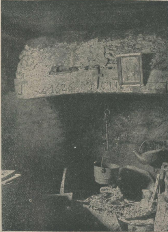
Fig. 3. Kaminecke aus einem Kücheninterieur.
