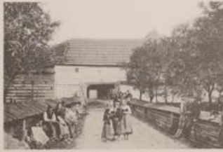
Fig. 1. Ansicht von der Südseite.
