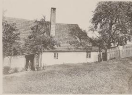
Fig. 8. Äußere Ansicht von der Westseite.
