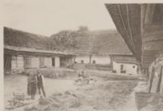
Fig. 5. Hofansicht gegen das Webgebäude.
