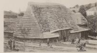
Fig. 2. Blick auf die Scheuer und Scheune.
