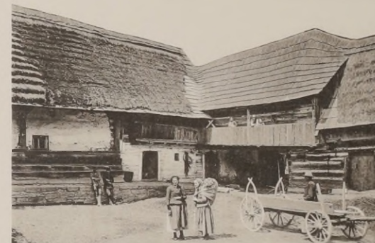
Fig. 4. Hofansicht gegen West.
