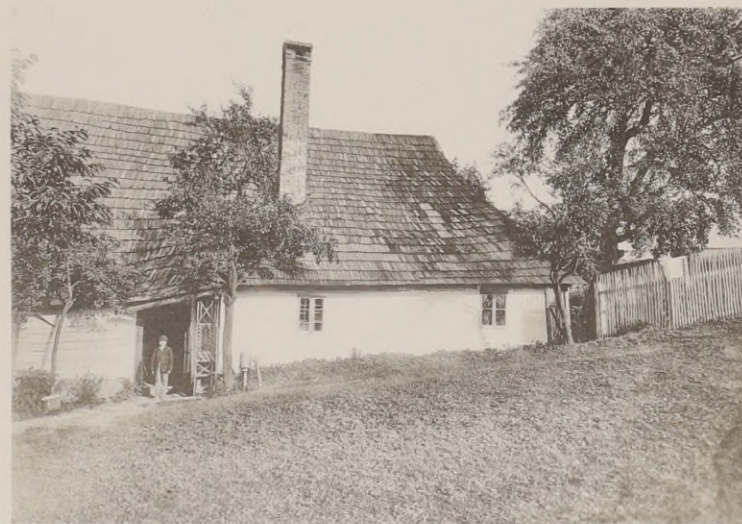
Fig. 8. Aeußere Ansicht von der Westseite.
