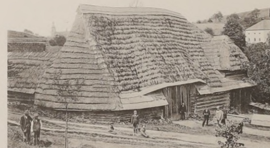
Fig. 2. Blick auf die Scheuer und Scheune.
